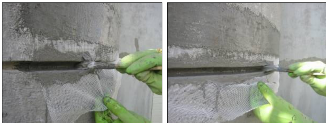
Figura 71 e 72 : Com a tela na posição vai-se aplicando a mistura para que a membrana seja formada.
