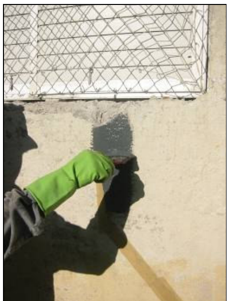
Figuras 47 e 48 : Aplicar a argamassa com uma trincha larga ou brocha.
