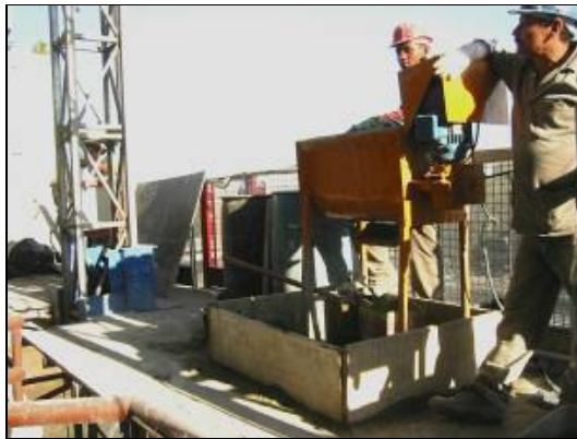
Figura 28 : Devido a sua grande capacidade de carga é possível fazer da plataforma uma área a mais como canteiro de obras.
