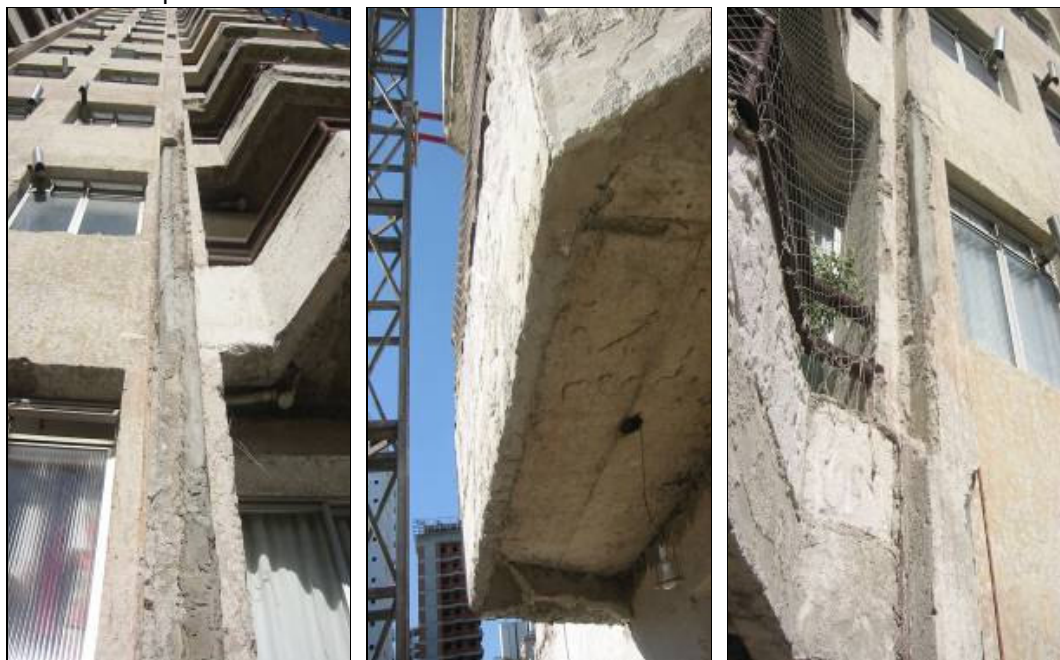
Figuras 42, 43 e 44 : Detalhe de pontos de armadura já tratados
