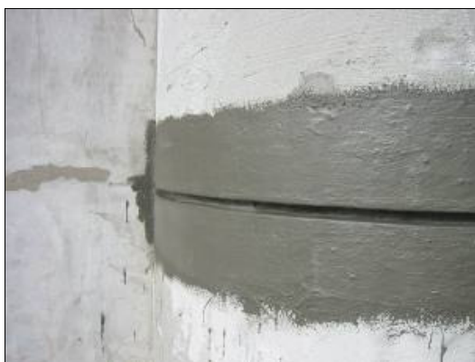
Figura 73: Resultado final obtido da membrana da junta de trabalho.
