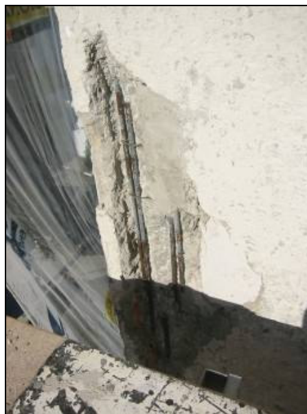
Figuras 40 e 41 : Durante a demolição geral as armaduras comprometidas já iam sendo descobertas para posterior tratamento
