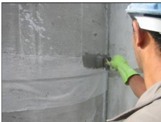
Figura 69: Aplica-se a mistura sobre a tela para que ela forme a membrana.
