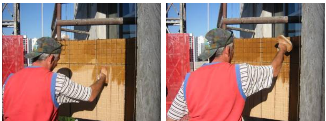
Figuras 60 e 61 : Soda caustica sendo aplicada sobre o papel da pastilha para a remoção do mesmo.
