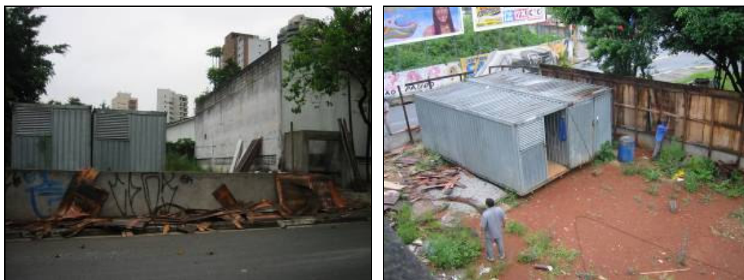
Figuras 23, 24, 25 e 26 : Instalação dos containeres em terreno vizinho ao prédio para o canteiro de obras.
