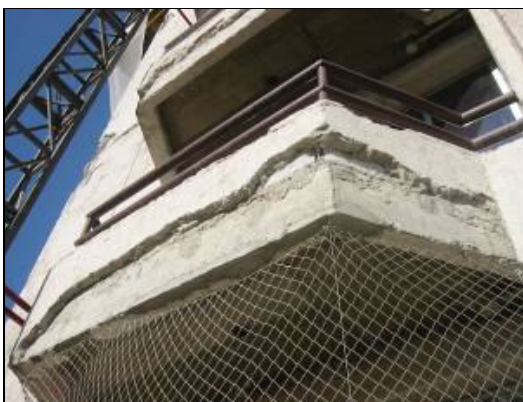
Figuras 35, 36, 37 e 38 : Em muitos casos a retirada do emboço chegava até a alvenaria
