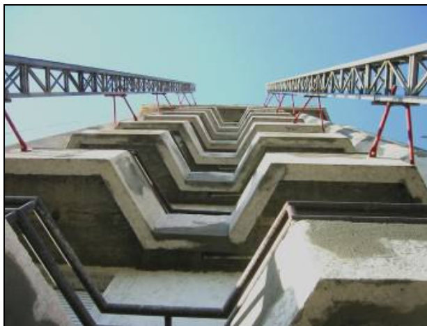
Figura 56 : As manchas mais escuras são as intervenções ocorridas para a recuperação do emboço retirado e para a correção da geometria dos terraços.
