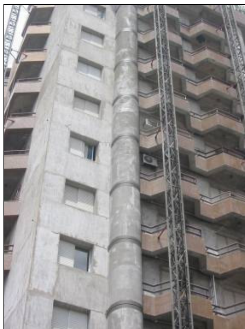
Figura 74: Detalhe na fachada principal das membranas executadas na coluna cilíndrica.
