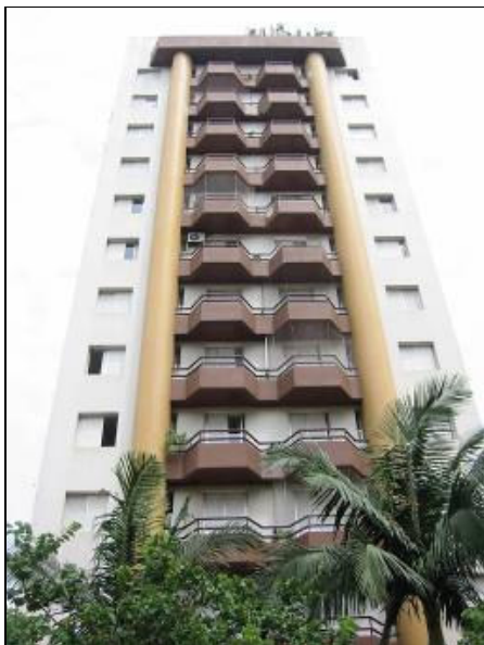
Figura 2 : Fachada principal ou face NE SE
