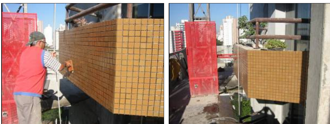
Figuras 64 e 65 : Com o papel retirado a área está pronta para receber o rejuntamento.
