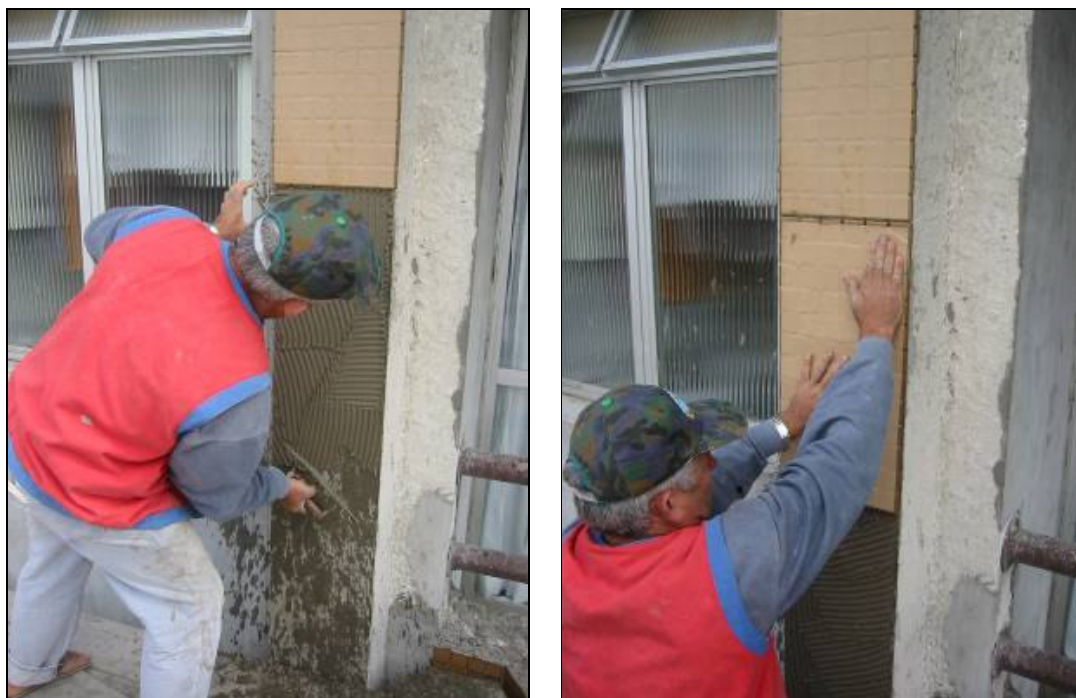
Figuras 58 e 59 : Colocação da pastilha cerâmica sobre a face externa das colunas salientes da fachada esquerda.
