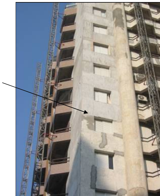
Figura 57 : No detalhe é possível ter uma noção do resultado final da regularização (a seta marca o ponto onde a regularização está parada).
