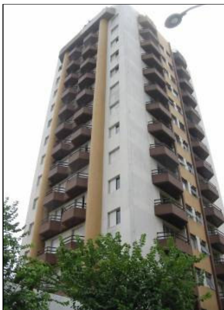
Figura 4 :Fachada dos fundos ou face SO
