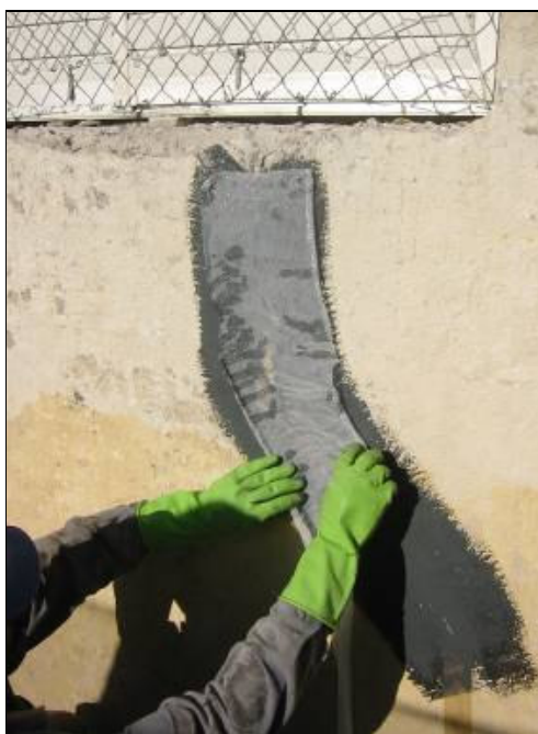
Figura 49 : Cortar tiras de 14 cm da largura de véu de poliéster. Aplicar a tela sobre o trecho preparado. Para emendar duas tiras utilizar transpasse mínimo de 5 cm.
