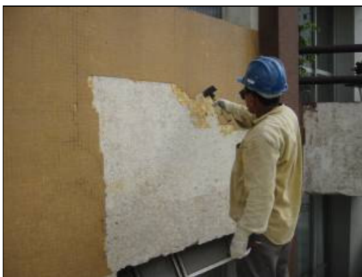
Figura 33 : Em 70% da área o material podia ser retirada apenas por simples percussão
