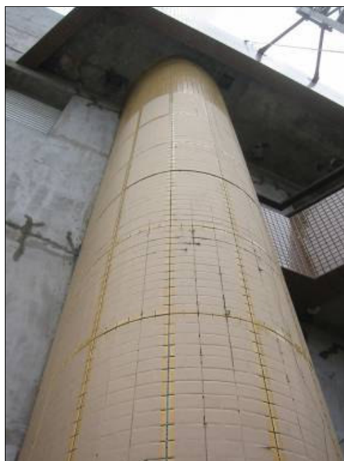
Figura 75 : Vista geral do revestimento pastilha aplicada nas colunas cilíndricas da fachada dos fundos entre o 12.º e 11.º andar.
