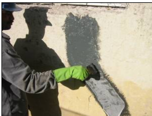
Figura 51 : Aplicar a camada seguinte, sempre iniciando de uma extremidade para outra, para expulsar o ar do interior da camada. Deve-se atentar para não exceder a espessura de 5 mm no preenchimento com argamassa flexível sobre o trecho demarcado. Aplicar de 2 a 3 demãos da argamassa de recuperação, totalizando uma espessura final da ordem de 2 a 3 mm.
