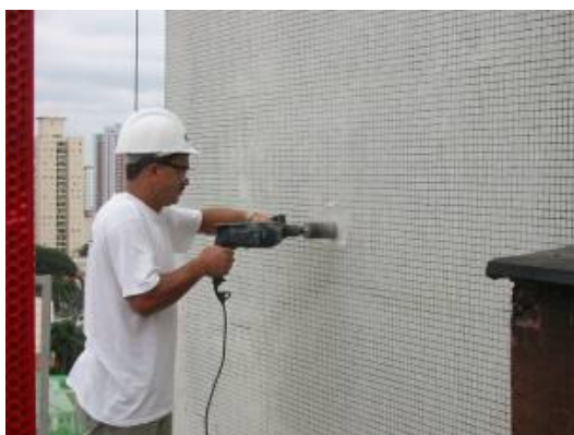
Figura 39 : Execução de uma das etapas do ensaio de aderência de argamassa
