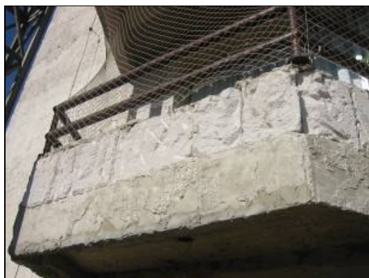
Figuras 35, 36, 37 e 38 : Em muitos casos a retirada do emboço chegava até a alvenaria
