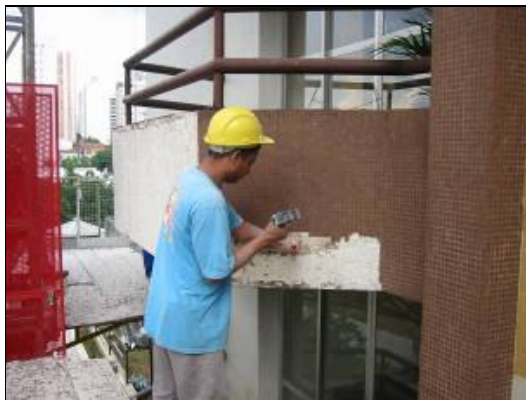
Figura 34 : Em 30% da área foi preciso mais que percussão para que as pastilhas fossem retiradas
