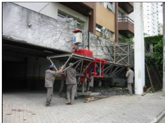
Figuras 30 e 31 : Plataforma sendo montada na fachada lateral direita
