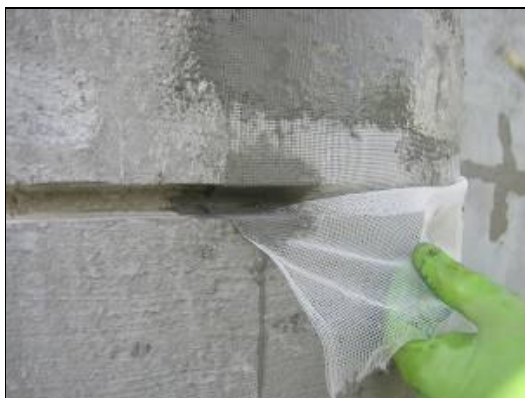
Figura 70 : Introduz-se a tela para dentro do sulco com o próprio cabo do pincel a aplica-se a mistura para uma primeira fixação da tela.
