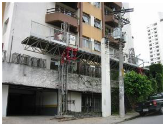
Figuras 30 e 31 : Plataforma sendo montada na fachada lateral direita
