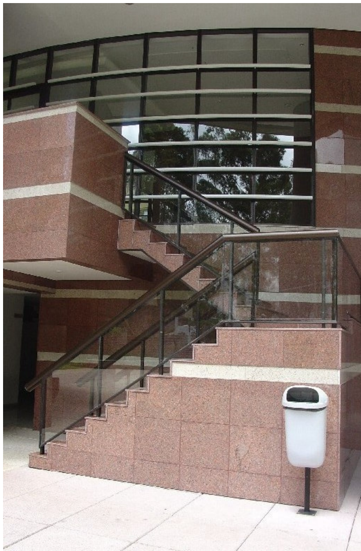
Foto 4.6 – Esquadria sobre escada
