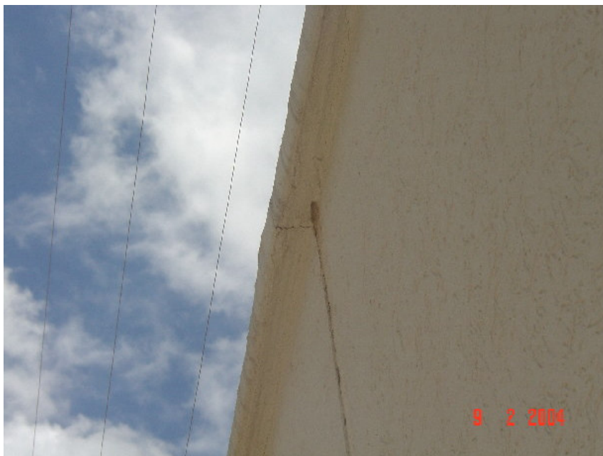
Foto 4.10 – Foto de um detalhe da pingadeira modificado
