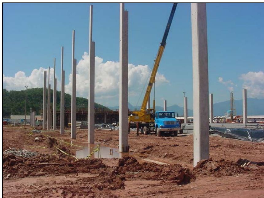
Figura 21: Preparação de pilares para o recebimento de tesouras metálicas
