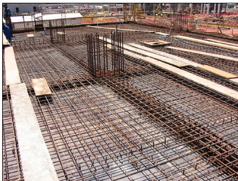
Figuras 12 e 13: Correto posicionamento e espaçamento das armaduras
