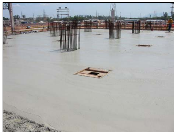
Figura 17: Acabamento parcial de concretagem
