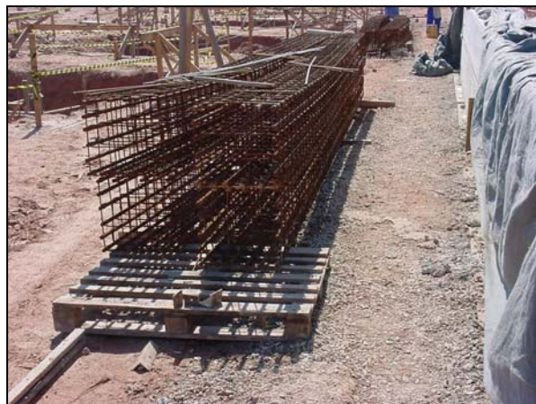
Figura 15: Peças aguardando içamento
