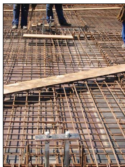
Figuras 12 e 13: Correto posicionamento e espaçamento das armaduras
