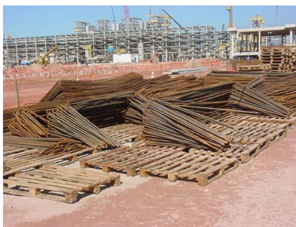
Figura 25: Barras dobradas separadas
