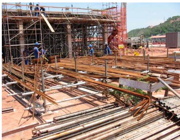
Figura 24: Colocação de barras em prateleiras
