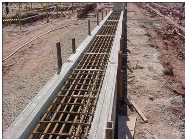
Figura 14: Posicionamento/limpeza em armaduras
