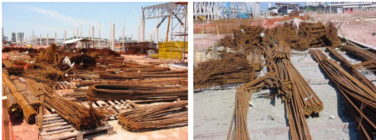
Figuras 22 e 23: Problemas com a estocagem e logística de materiais
