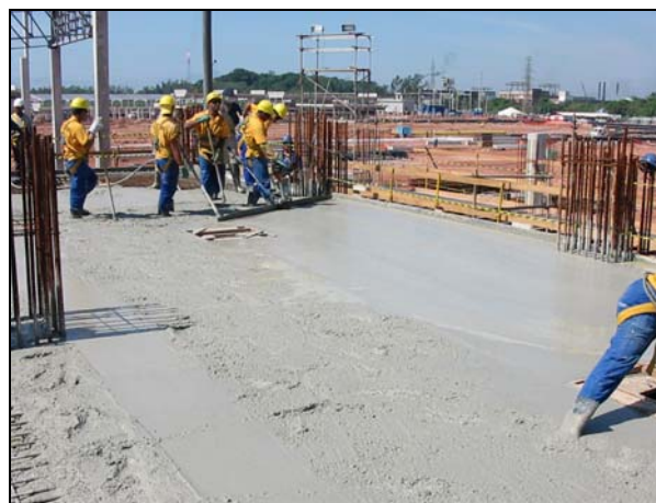
Figura 16: Concretagem de laje
