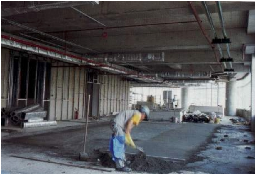
Figura nº 5.38– Vista das tubulações do ar condicionado (Fonte: Banco de Boston, 2002)
