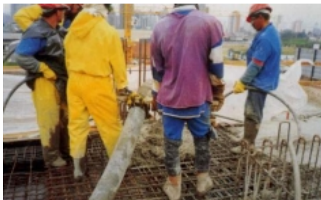
Figura nº 5.34– Vista da concretagem (Fonte: Banco de Boston, 2002)
