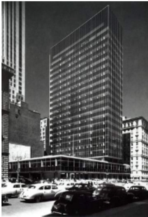
Figura 2.9 - Ilustração do Edifício da Administração da Lever Brothers Company, em Nova Iorque (1951-1952) - Skidmore, Owings & Merrill. (Fonte: Gössel, 2001).
