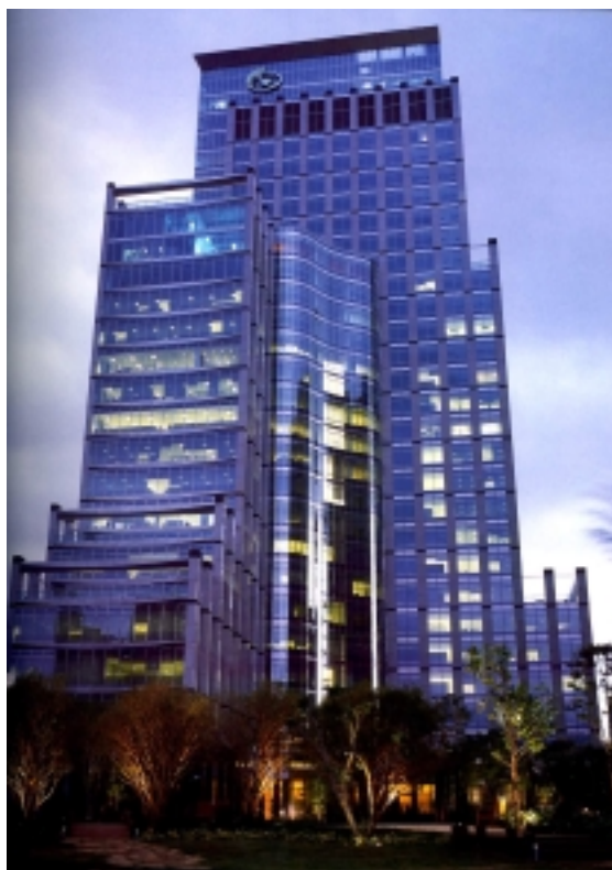
Figura nº 5.26 – Banco de Boston: vista do edifício (Fonte: Revista Projeto 269, 2002)
