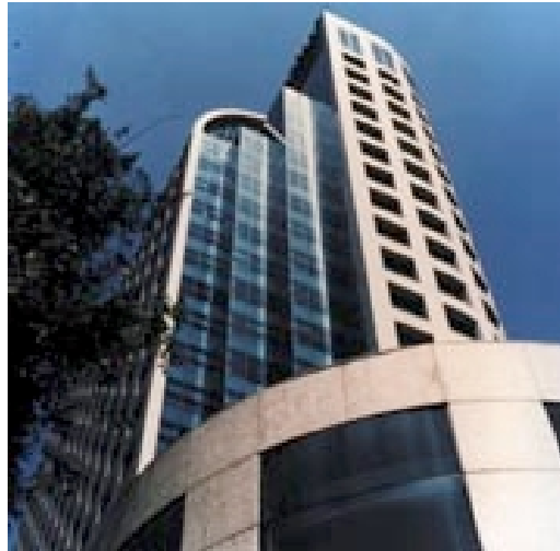
Figura nº 5.10 – Fachada do Edifício – cortina de vidro / grelha (Fonte: CBPO,1986)
