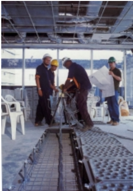
Figura nº 5.37– Vista da instalação do piso elevado (Fonte: Banco de Boston, 2002)
