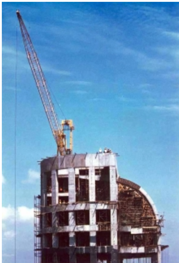
Figura nº 5.7 – Execução da pérgula (Fonte: CBPO,1985)
