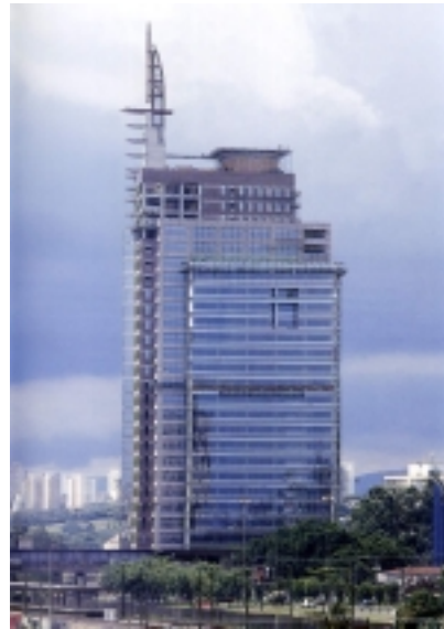
Figura nº 5.24 – A fachada sul
