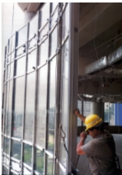
Figura nº 5.35– Vista da colocação dos caixilhos (Fonte: Banco de Boston, 2002)
