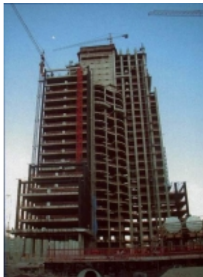
Figura nº 5.33– Vista da estrutura de concreto (Fonte: Banco de Boston, 2002)
