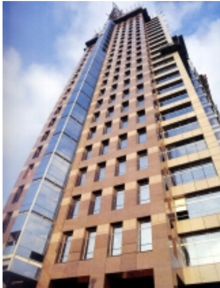
Figura nº 5.23 – A fachada leste (Fonte: Revista Projeto 205 ,1997)
