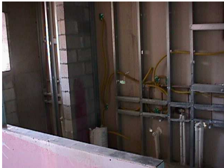
FIGURA 13 – FOTOS DO SISTEMA CONSTRUTIVO DE VEDAÇÃO UTILIZADO NA COZINHA
