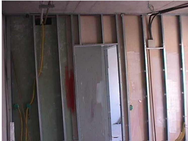
FIGURA 12 – FOTOS DO SISTEMA CONSTRUTIVO DE VEDAÇÃO UTILIZADO NA SALA
