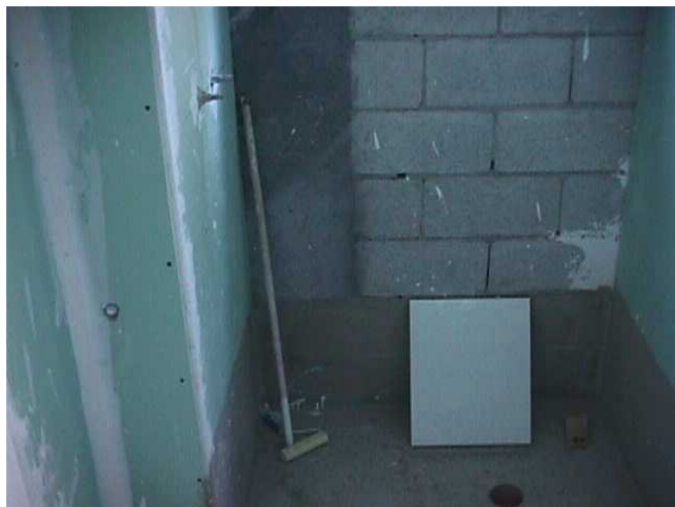
FIGURA 14 – FOTOS DO SISTEMA CONSTRUTIVO DE VEDAÇÃO UTILIZADO NO BANHO
