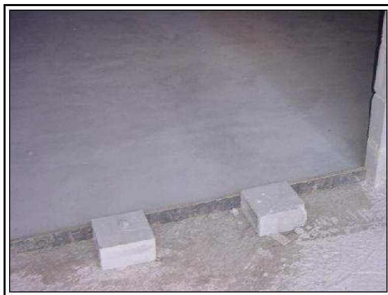
Figura 4: Detalhe do contrapiso racionalizado desenvolvido pela Prof. Dr a Mércia Barros que é utilizado pela TIBÉRIO engenharia e passou a ser aplicado também pela MPD.
