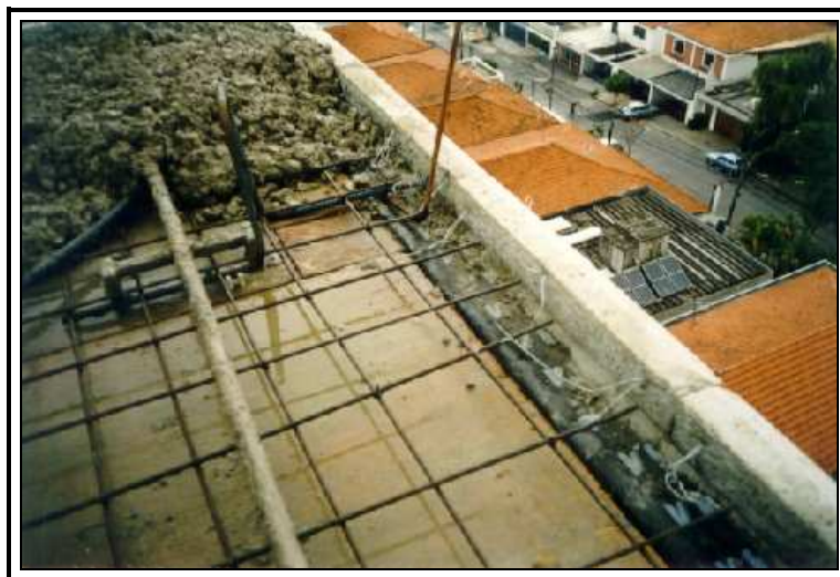
Figura 12: Percebe-se na extremidade da laje que esta sendo concretada a colocação de moldura de cimento que junto com a manta asfáltica permitem que as deformações da laje de cobertura não sejam transmitidas para as alvenarias do último andar
