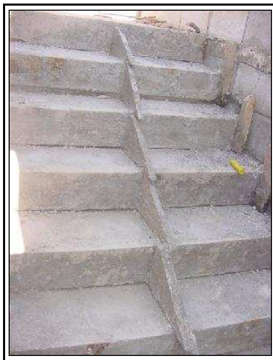
Figura 7: escada recém concretada em obra da TIBÉRIO, antes da entrega do empreendimento a escada recebe tratamento de concreto
