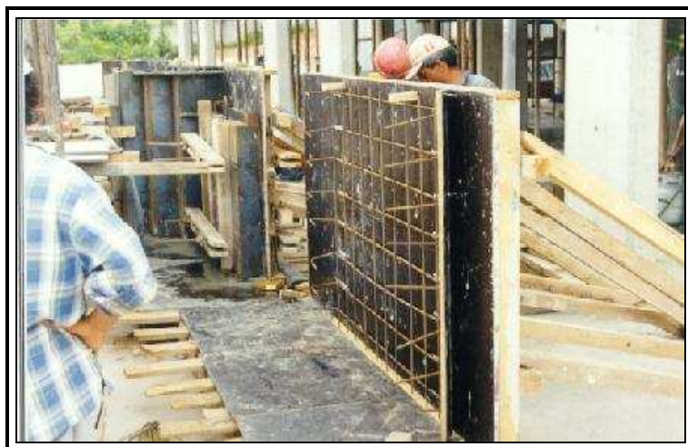
Figura 6: Detalhe do canteiro de moldagem das escadas no pavimento térreo da edificação. Deste local as escadas foram içadas por grua telescópica até seu local definitivo
