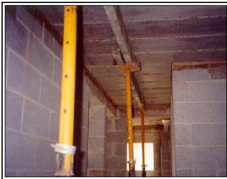
Figura 2: Detalhe do escoramento inferior das lajes tipo painel. Verifica-se nesta foto que este sistema permite uma liberdade de trabalho no pavimento inferior à laje.
